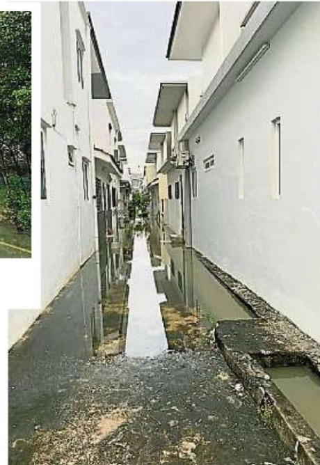
由于排水不及，住宅区后巷也出现积水情况。
